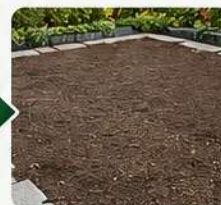
5 Listo para la dosificación e instalación.
